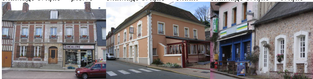
chaînage pierre + brique chaînage pierre + enduit chaînage pierre + pierre
