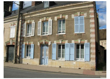
chainage pierre/brique + enduited
